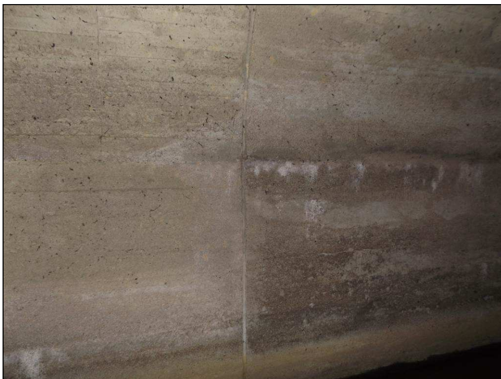
Obr. č. 6 - pohled na vybranou dilatační spáru objektu vyplněnou pevnou a zdravou cementovou maltou
