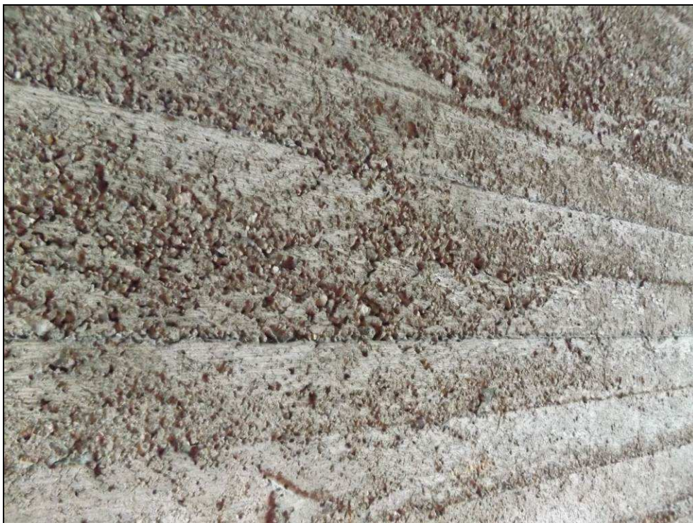
Obr. č. 5 - pohled na drobné opady betonu do hl. cca 5 mm v líci vybrané opěry objektu
