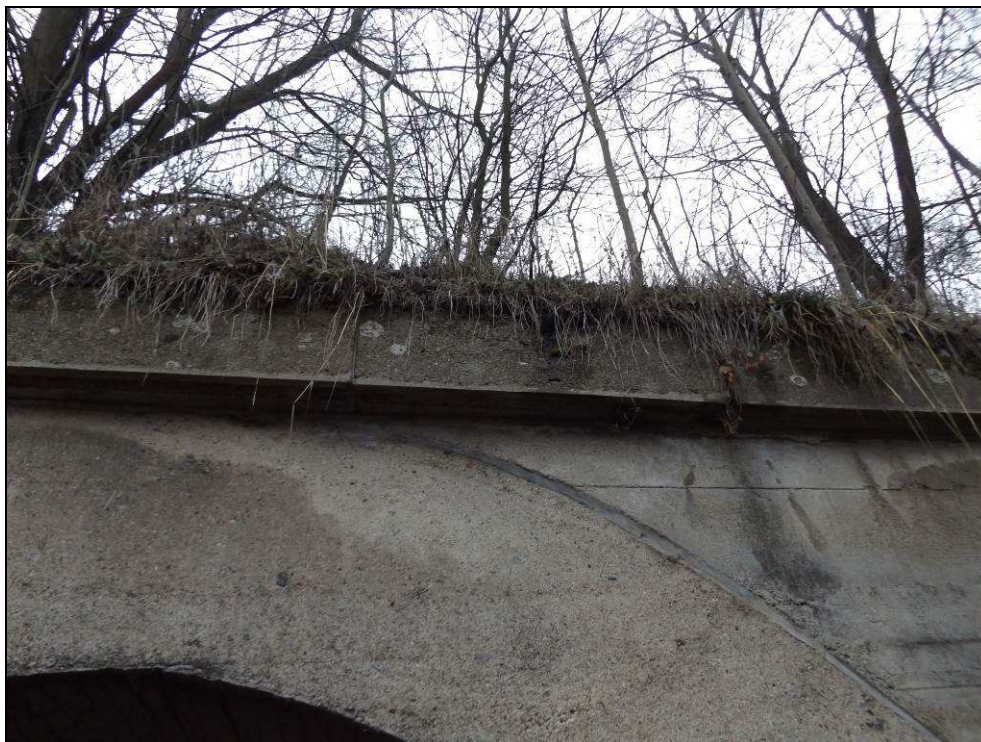
Obr. č. 8 - pohled na betonové „tvarovky“ vybrané římsy objektu
